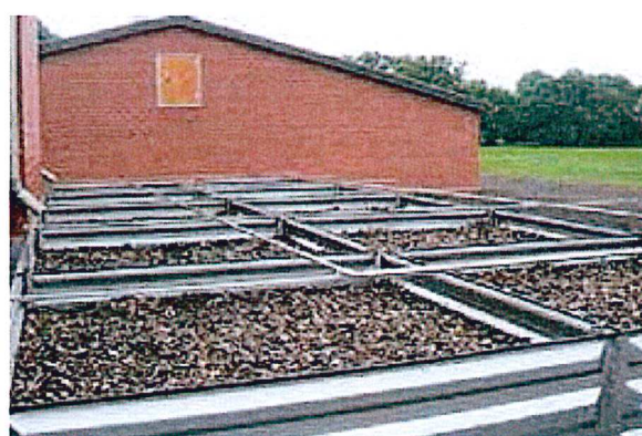
Abbildungen 4 und 5: Stallabluftreinigung mit Biofiltern (organische Filtersubstrate)
