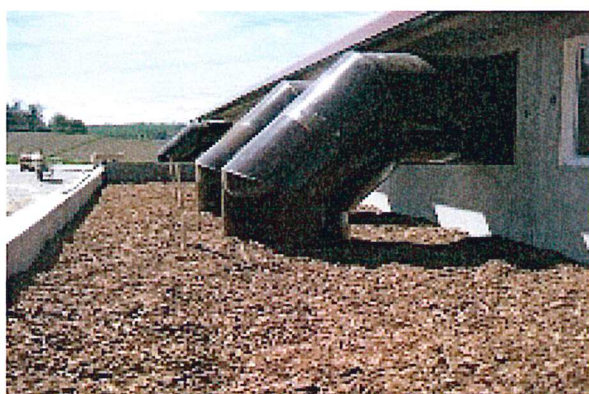
Abbildungen 4 und 5: Stallabluftreinigung mit Biofiltern (organische Filtersubstrate)
